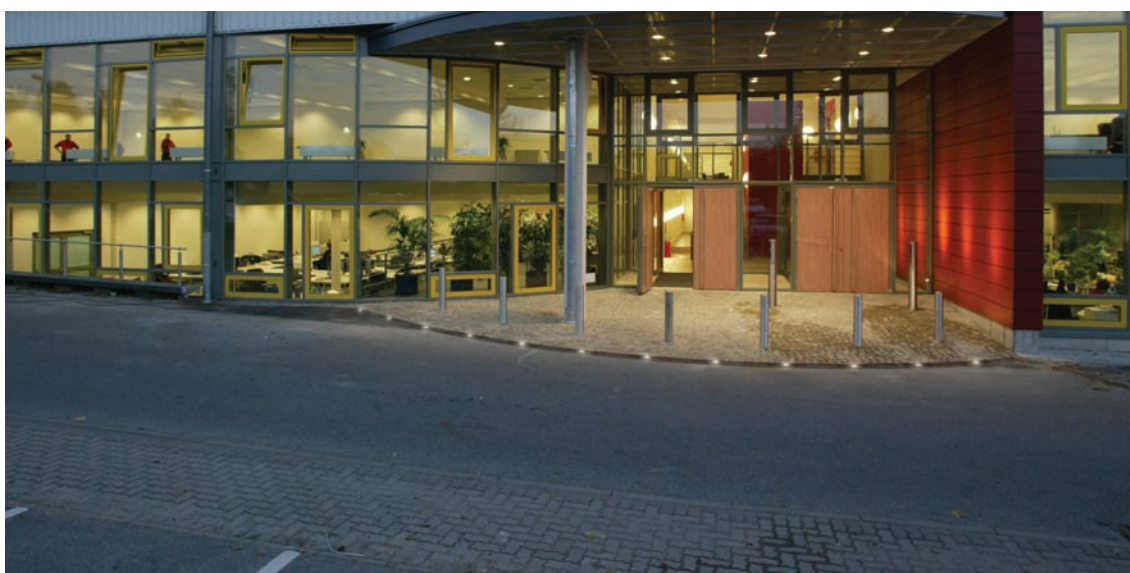
ACO Light point на входной площадке перед офисным зданием
